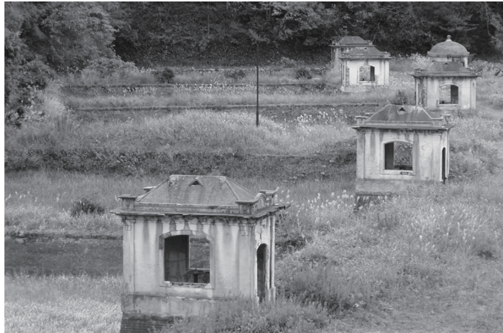
写真: 旧美敷水源地下水道施設...鳥取市民の飲料水の確保と公衆衛生の向上を主な目的として大正4年より昭和53年まで供用された上水道施設です。山陰初の近代水道施設の代表的遺構であり、貯水池のみならず量水施設や濾過施設なども良好な状態で保存されています。近代水道施設の構成を知る上で高い歴史的価値が認められ、今年国の重要文化財に指定されました。
